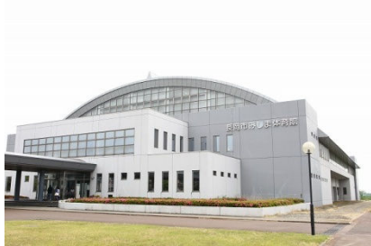
長岡市みしま体育館・外観
